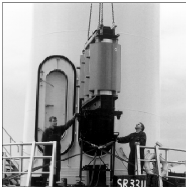
Den 6 tons tunge transformere hejses ind gennem døren, som netop er stor nok. Inde i møllen skal transformeren hejses op til 3. sal. Foto: Jørgen Holm Christensen
