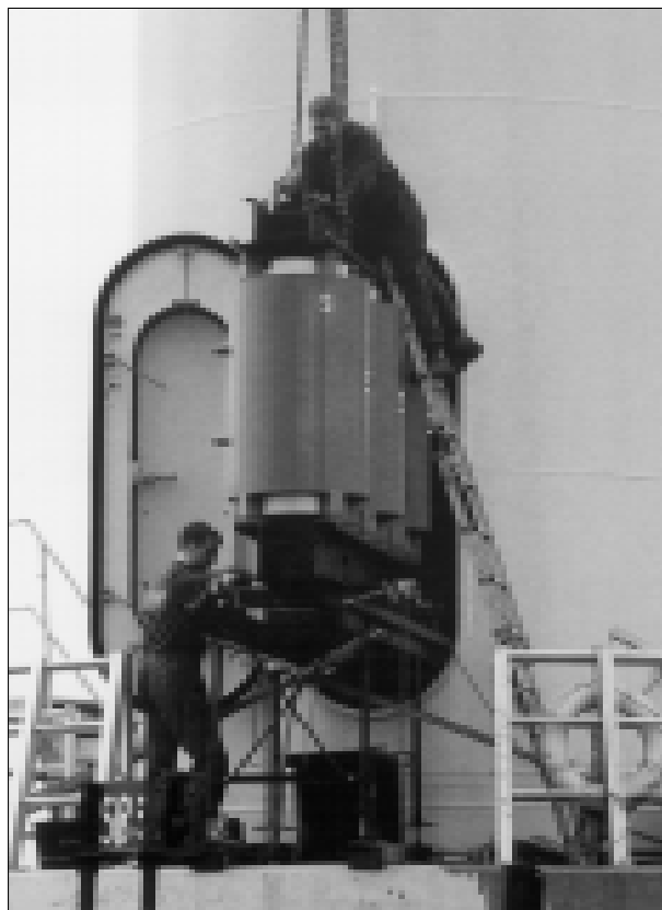
Den 6 tons tunge transformere hejses ind gennem døren, som netop er stor nok. Inde i møllen skal transformeren hejses op til 3. sal. Foto: Jørgen Holm Christensen
