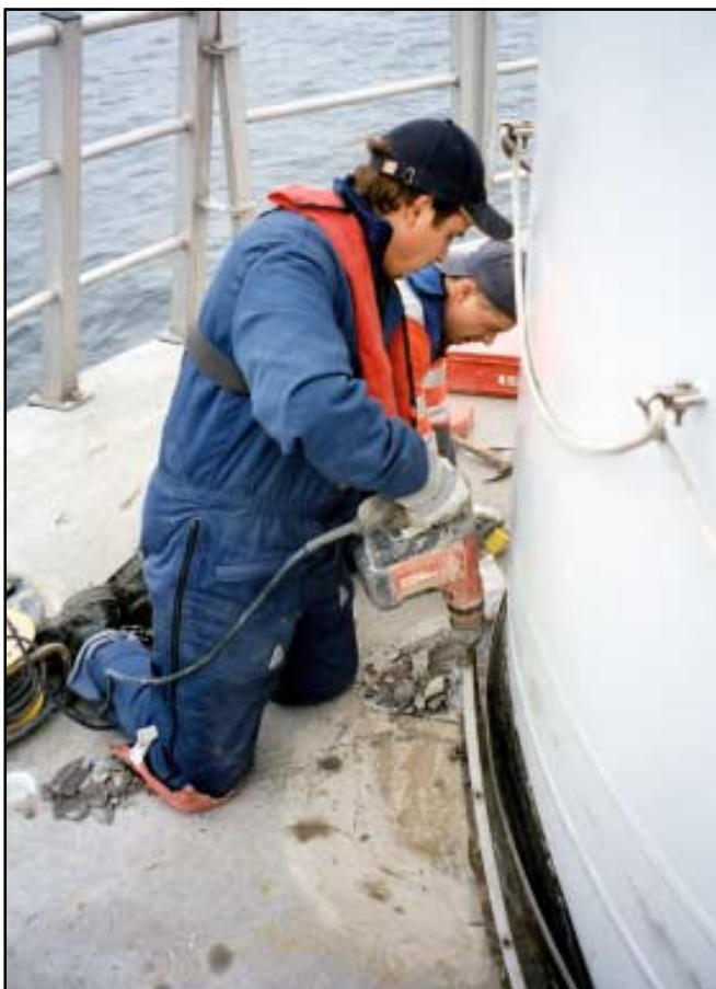
Nogle mindre betonskader repareres under garantien af folk fra Monberg og Pihl.
