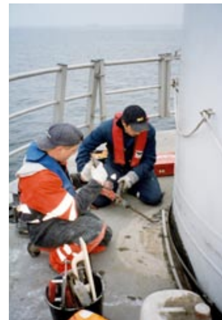
M&P folk igang med reparation af afknækket betonstykker
